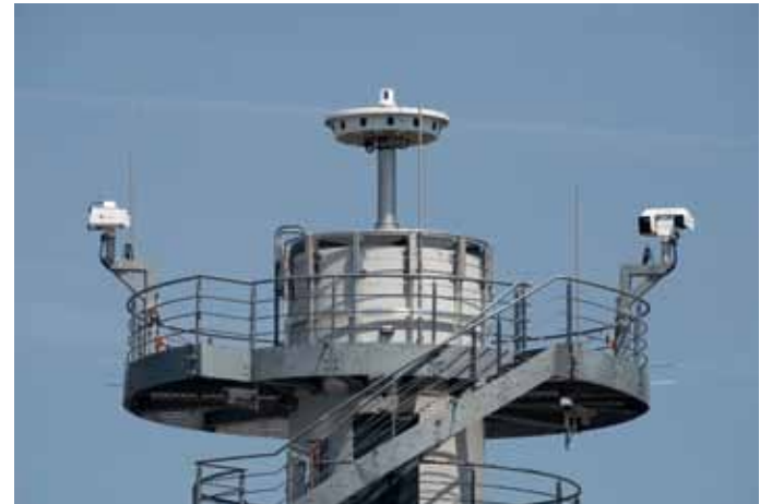
Blick auf den RTC (Remote Tower Control) Kameraturm der DFS in Saarbrücken
