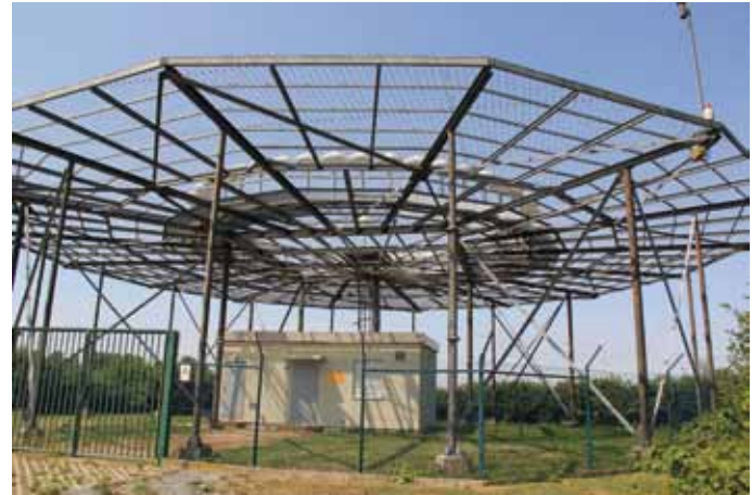
Das Doppler-UKW Drehfunkfeuer DVOR Ried bei Darmstadt ist für den Frankfurter Flughafen eine wichtige Einrichtung der Flugsicherung
